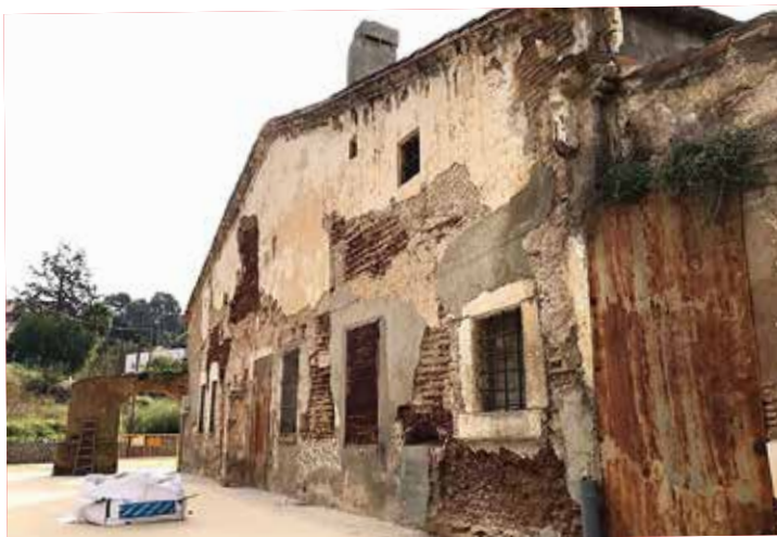
S'han iniciat els treballs de rehabilitació de l'eixida i de la coberta petita de la masia de Can Freixes, un edifici públic catalogat que forma part del Patrimoni Arquitectònic de Catalunya
