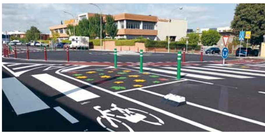
▲ Obres carril bici C/ Ponce de León.
