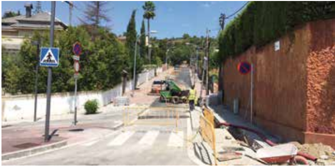
Reurbanització del c. Pont
