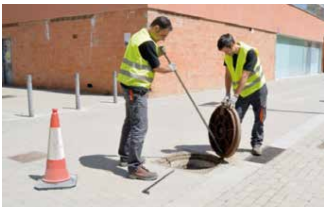
Tractament de clavegueram amb pintura insecticida per a paneroles
