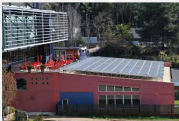
Coberta de la piscina municipal La Bonaigua
