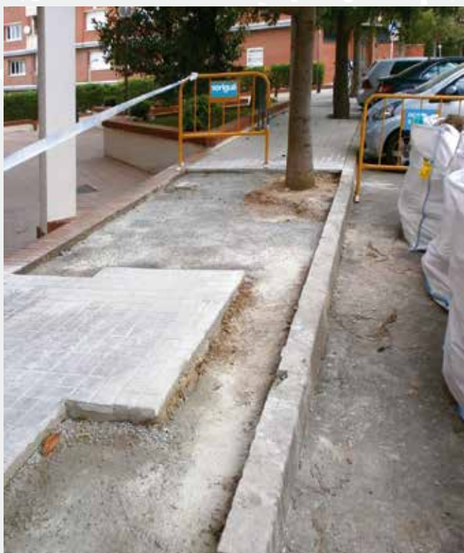
Actuació realitzada a l'av. de la Generalitat de Catalunya, 3. Arranjament de vorera i escocell
